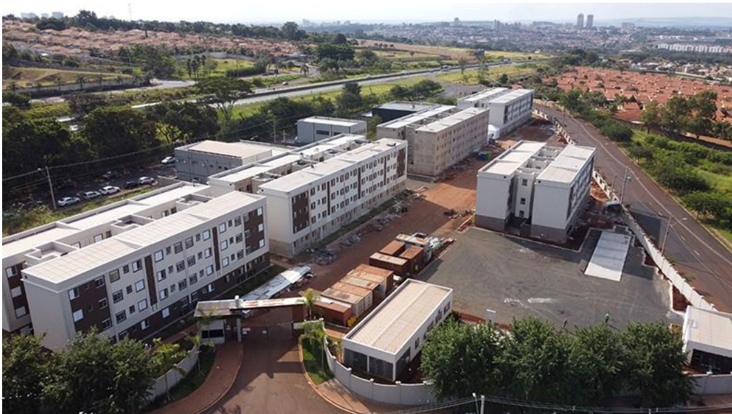
Figura 10 – Visão da obra em estudo.
