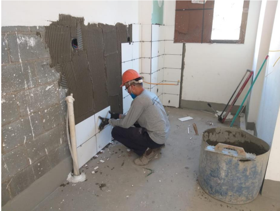
Figura 5 – Execução do serviço de revestimento cerâmico.
