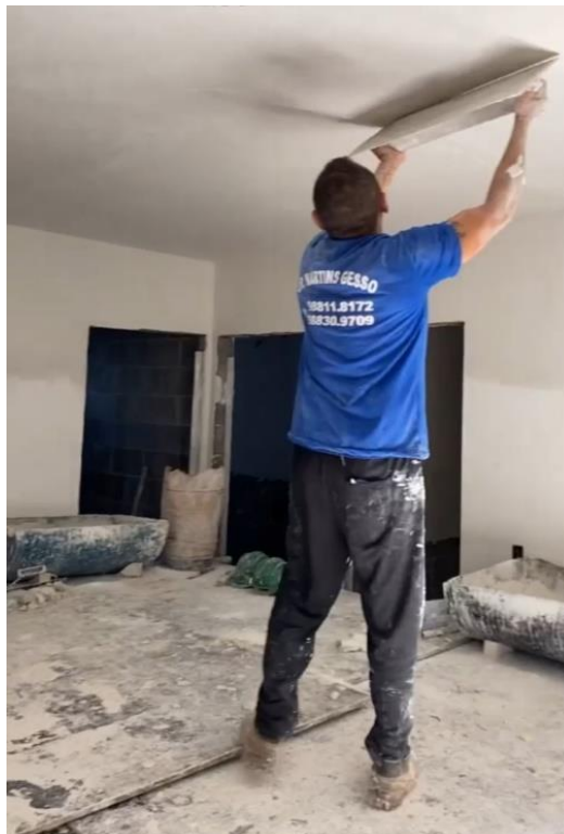
Figura 4 – Execução do serviço de revestimento em gesso liso.
