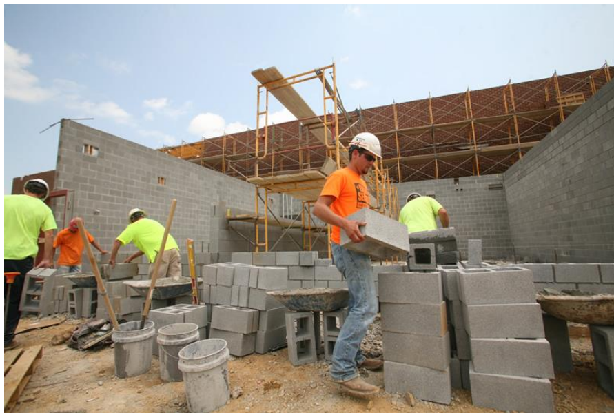
Figura 2 – Mão-de-obra executando serviço de alvenaria.
