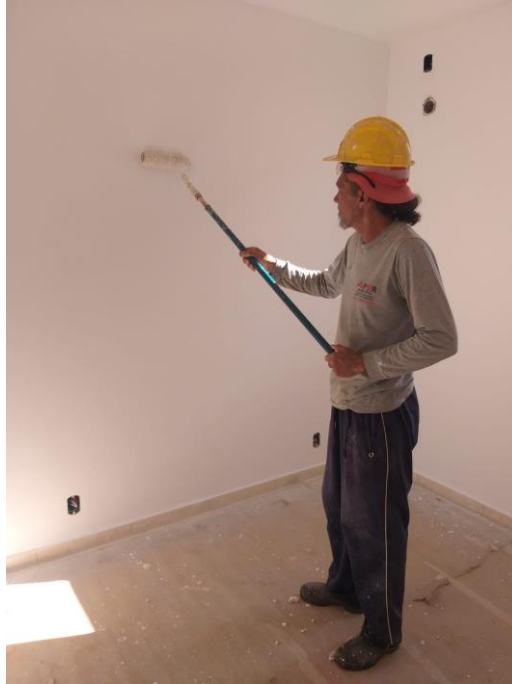
Figura 7 – Execução de pintura interna com rolo.
