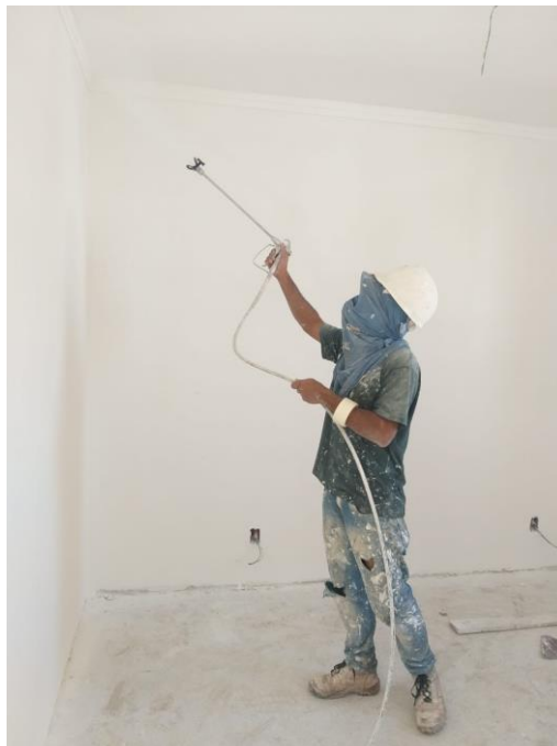
Figura 8 – Execução de pintura interna com Airless.
