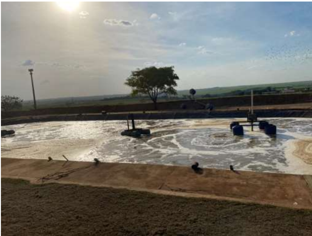
Figura 16. Lagoa de Aeração
