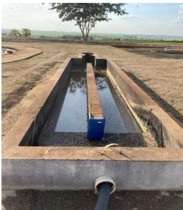
Figura 15. Calha Parshal
