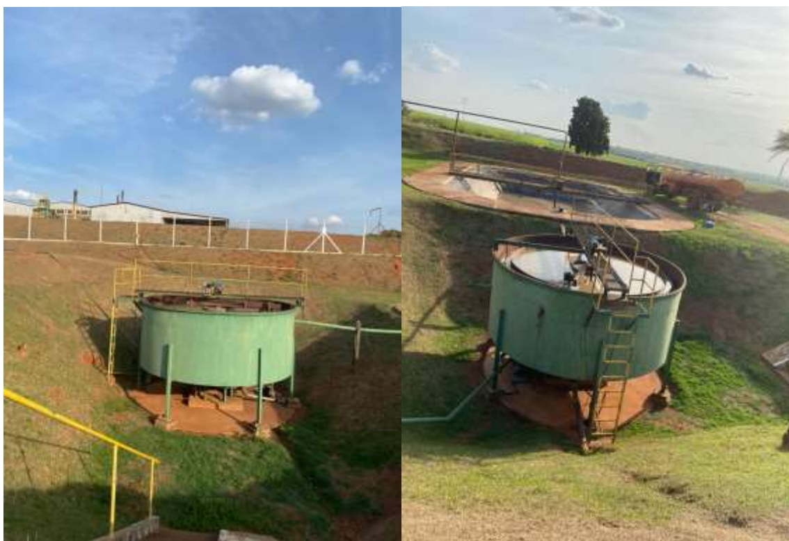
Figura 17. Decantador
