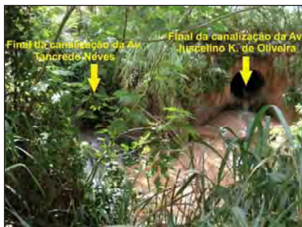
Figura 54: Final das canalizações da Avenida Tancredo Neves e de parte da Avenida Pres. Juscelino K. de Oliveira.
