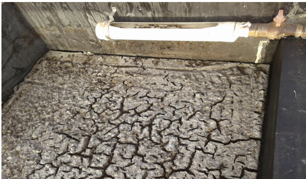
Figura 37 - Aspecto do lodo do T1 T1 com 9 dias de secagem: fenômeno rachadura.
