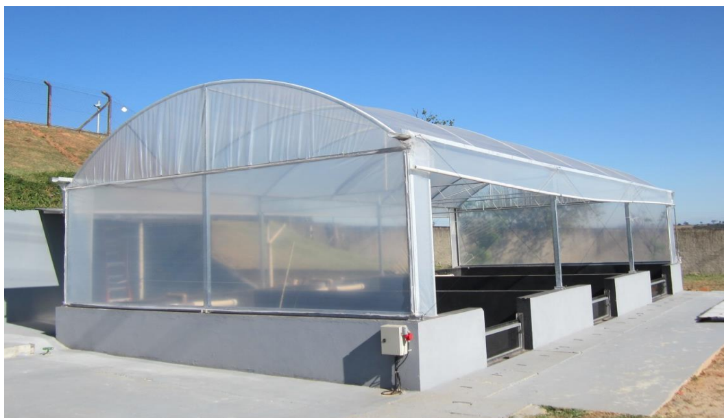
Figura 21 - Vista do leito de secagem.
