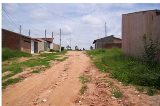
Figura 57: via onde foi utilizado RCD pra manutenção (a) e com problemas de drenagem, após entulhamento (b)
