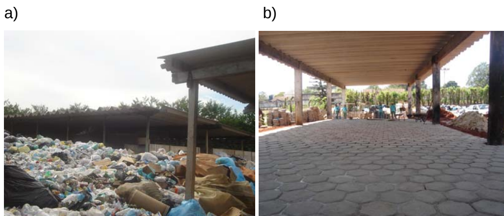
Figura 41: vista da Central de Triagem de Materiais Recicláveis em 2006 (a) e em 2007 (b)
