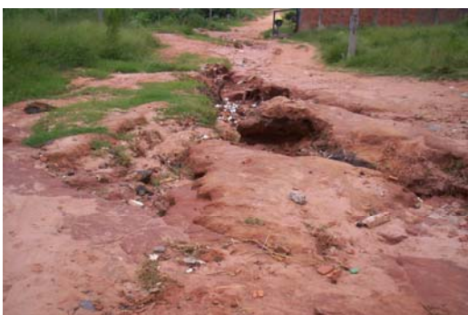
Figura 57: via onde foi utilizado RCD pra manutenção (a) e com problemas de drenagem, após entulhamento (b)
