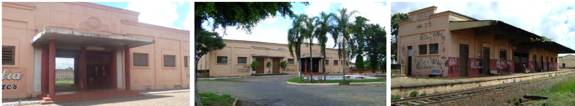
Figura 08. Fotos da Estação Ferroviária de Mirassol nos dias de hoje (Vista Frontal e Posterior)
