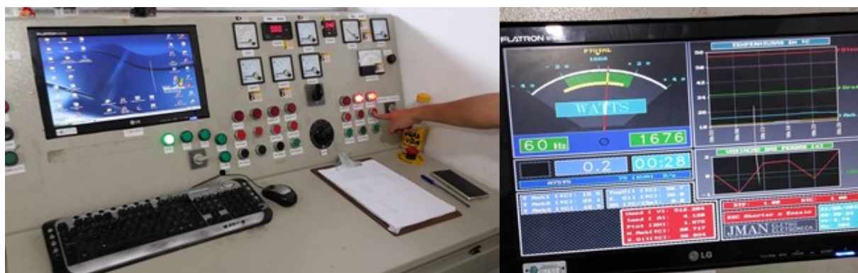
Figura 22 – Interface do software utilizado no ensaio de elevação de temperatura no transformador de distribuição
