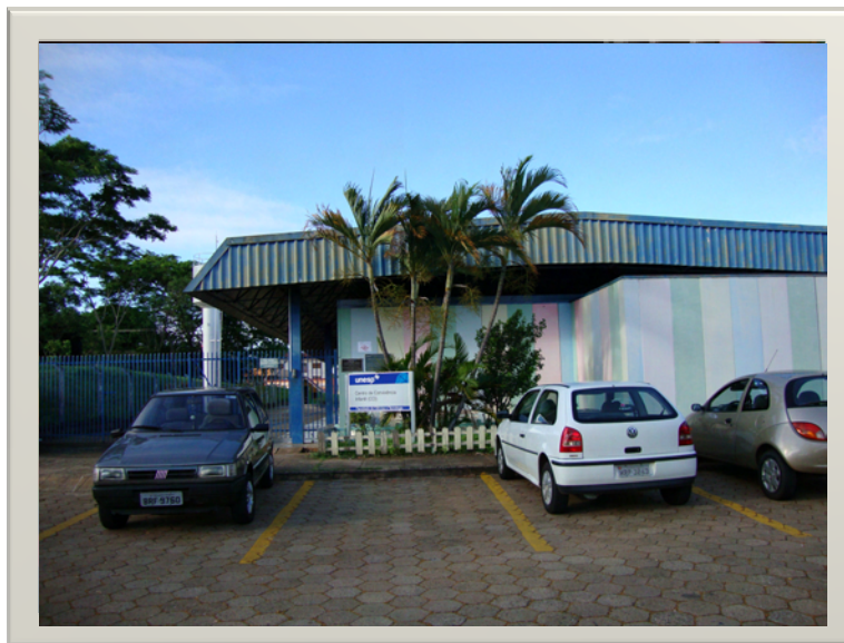
Figura 2: Prédio da Creche
