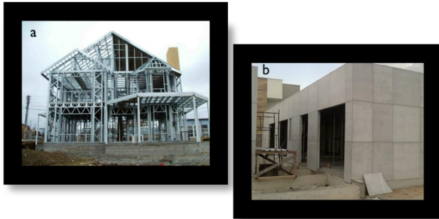
Figura 4 - Estrutura para aplicação da placa cimentícia no sistema LSF (a) e aplicação das placas cimentícias em vedação externa da edificação (b).
