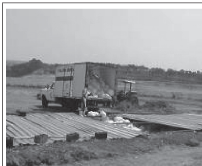
Figura 4 – Disposição dos RSS em valas sépticas, no aterro sanitário do município de Bauru (fonte: LOPES, 2007).
