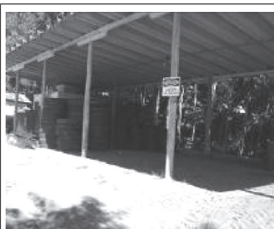
Figura 5 – Barracão onde são armazenados os pneus.
