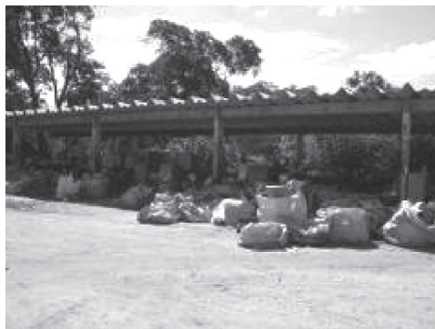
Figura 2 – Galpão de recebimento de materiais recicláveis ainda aguardando triagem.
