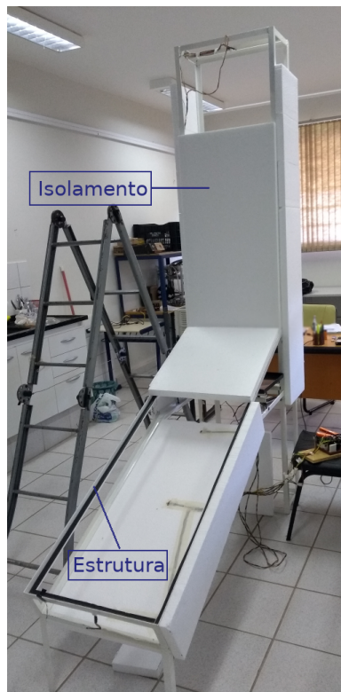
Figura 4.1: Secador solar em fase inicial de construção: estrutura metálica e isolamento térmico. Fonte: Autor (2021).
