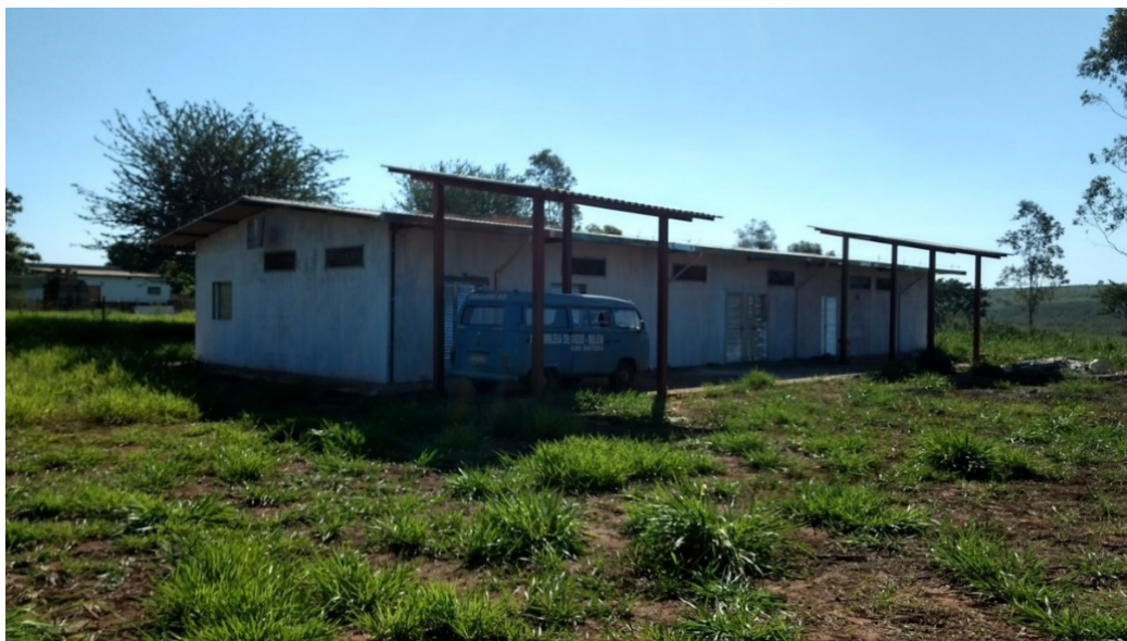
Figura 15 – UPA em construção
