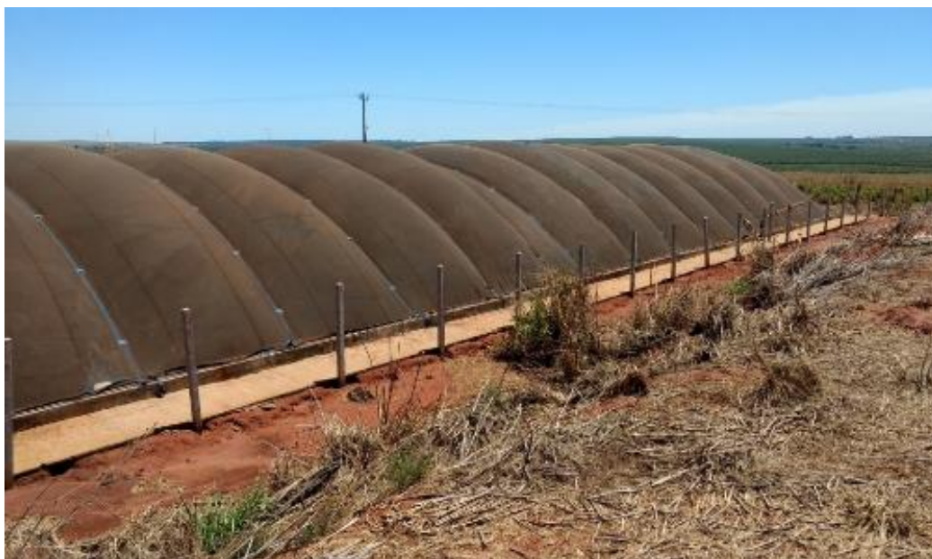
Figura 8 – Biodigestor modelo canadense
