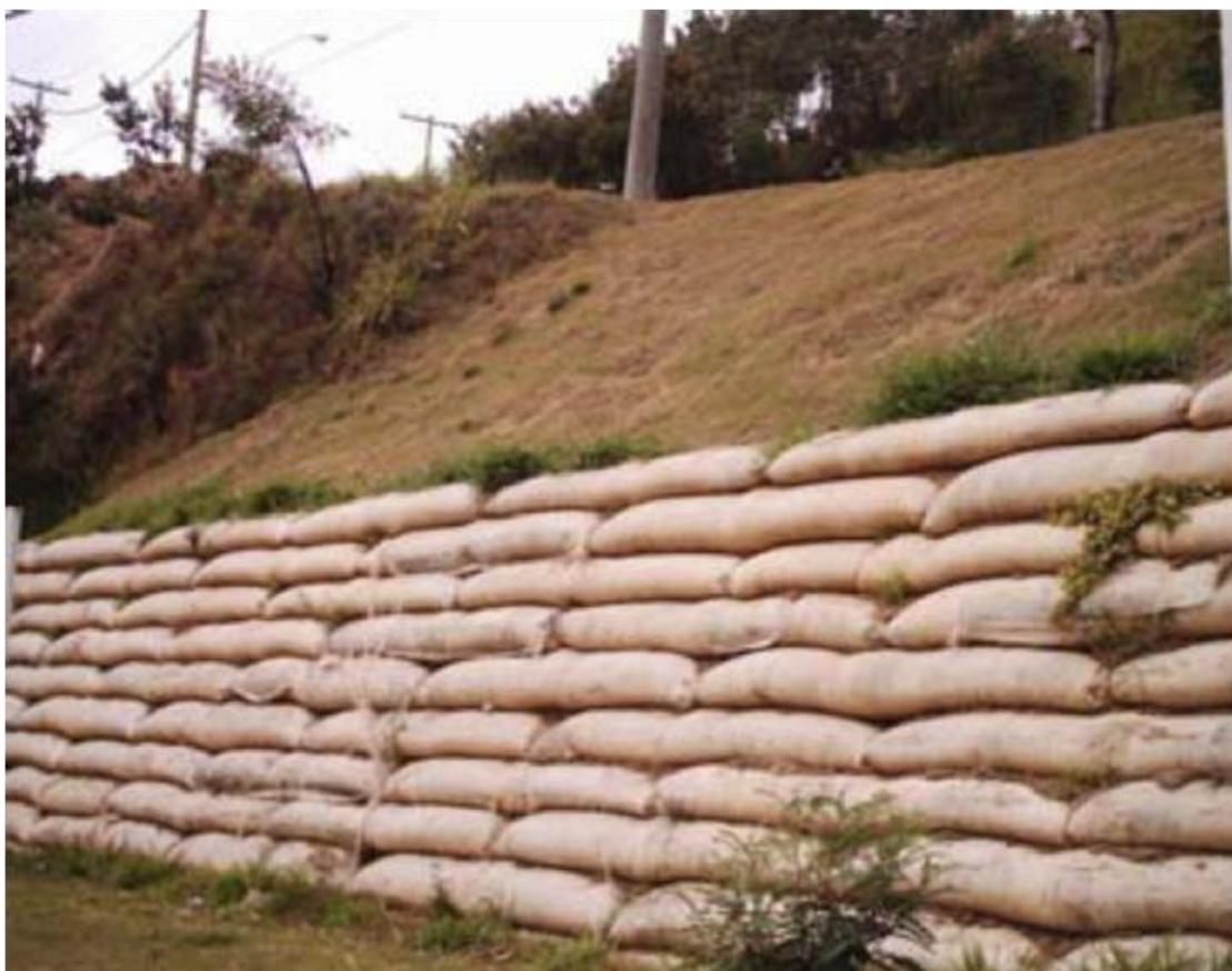
Figura 5 – Muro de Sacos de Solo-cimento.
