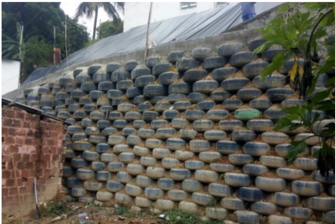
Figura 6 – Muro de Pneus.
