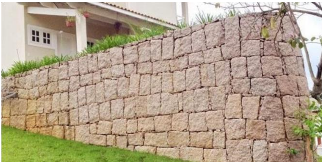
Figura 1 – Muro de Alvenaria de Pedra.
