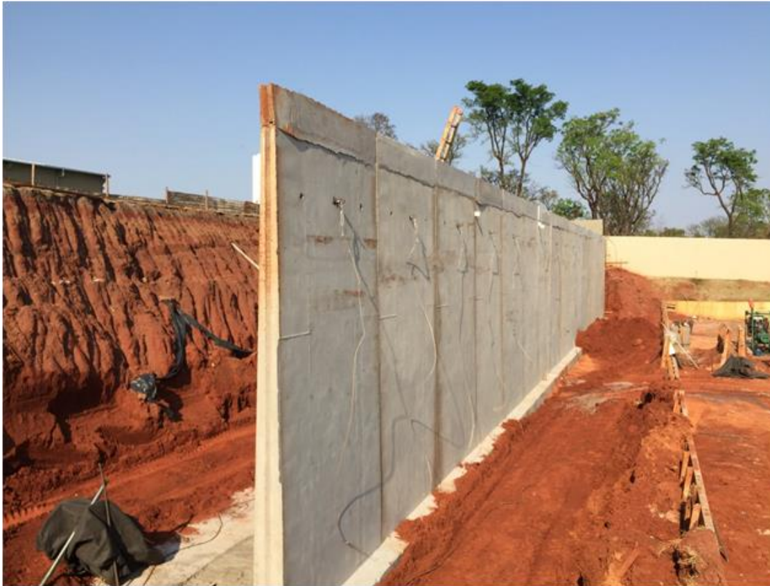
Figura 7 – Muro de Flexão.
