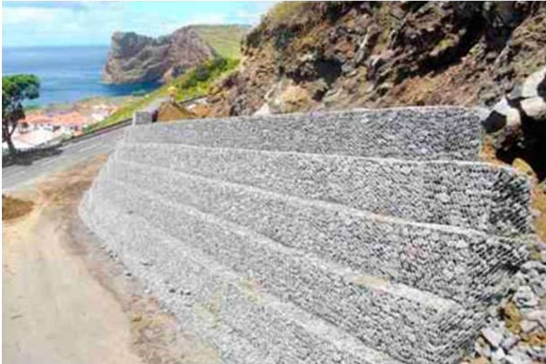
Figura 3 – Muro de Gabião.
