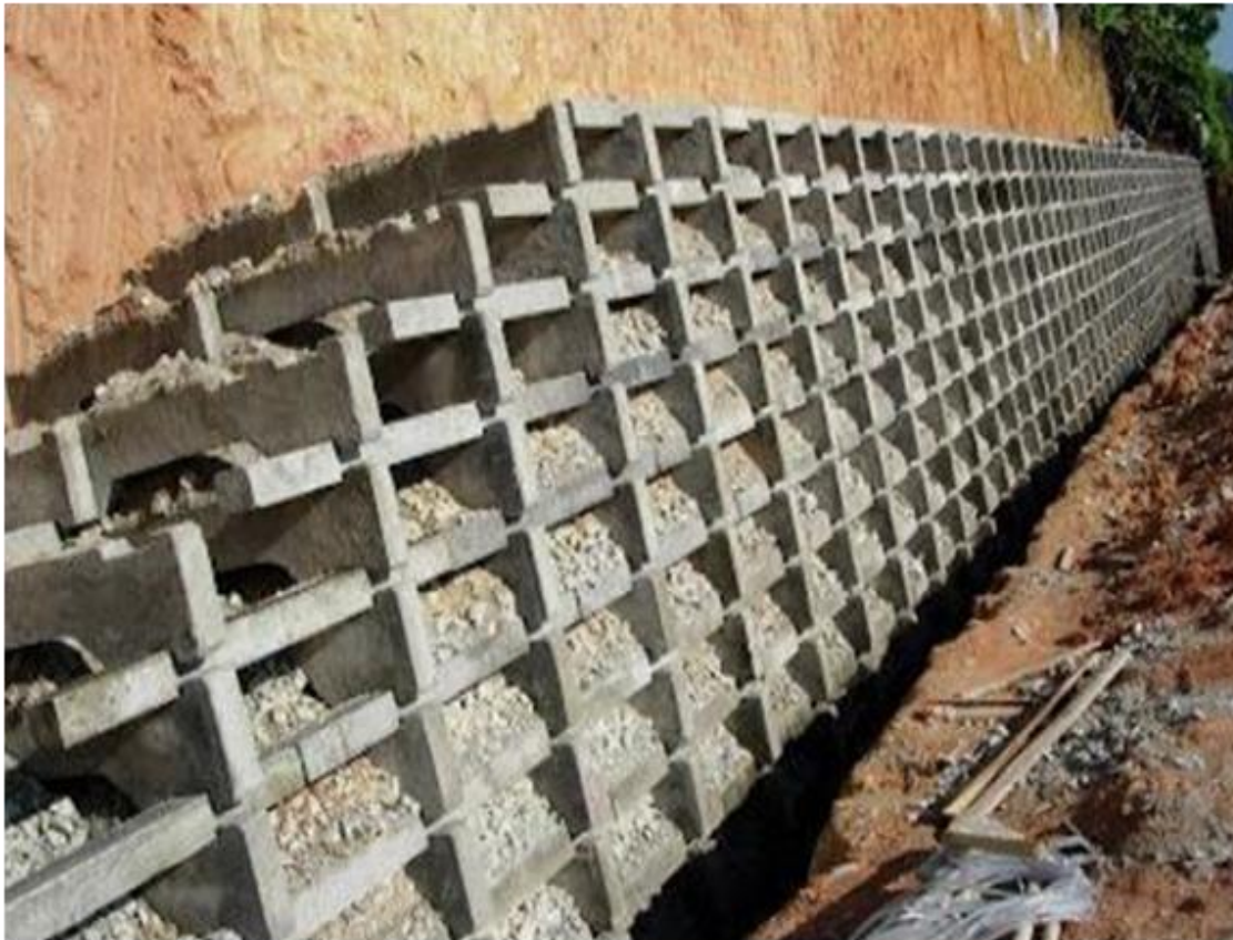
Figura 4 – Muro em fogueira (crib-wall).
