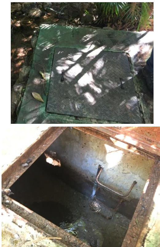
Figura 10 - Nos seis pontos visitados onde a água termal jorra naturalmente do chão foram feitas construções como a da foto acima a fim de se isolar e proteger as fontes do contato com o meio exterior.
