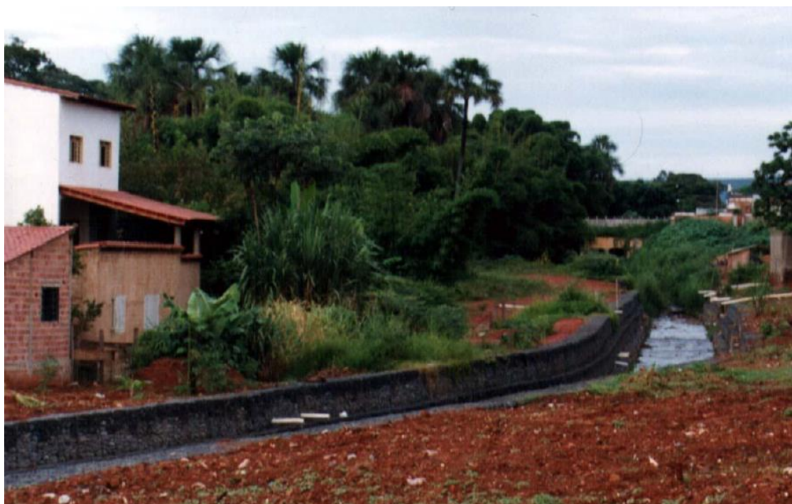
Figura 94 - Ponto de descarga de esgoto doméstico no Córrego do Açude (Biella, 2009).
