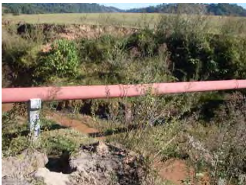
Figura 60: Travessia aérea do curso d'água com uso de conduto feito de ferro dúctil.
