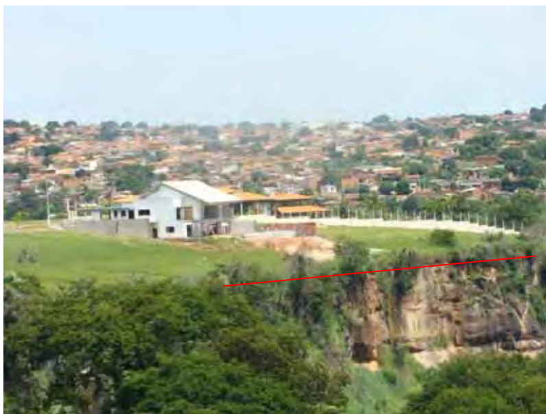
Figura 25: Casa de condomínio fechado próximo a escarpa. Foto tirada em 07/2007.
