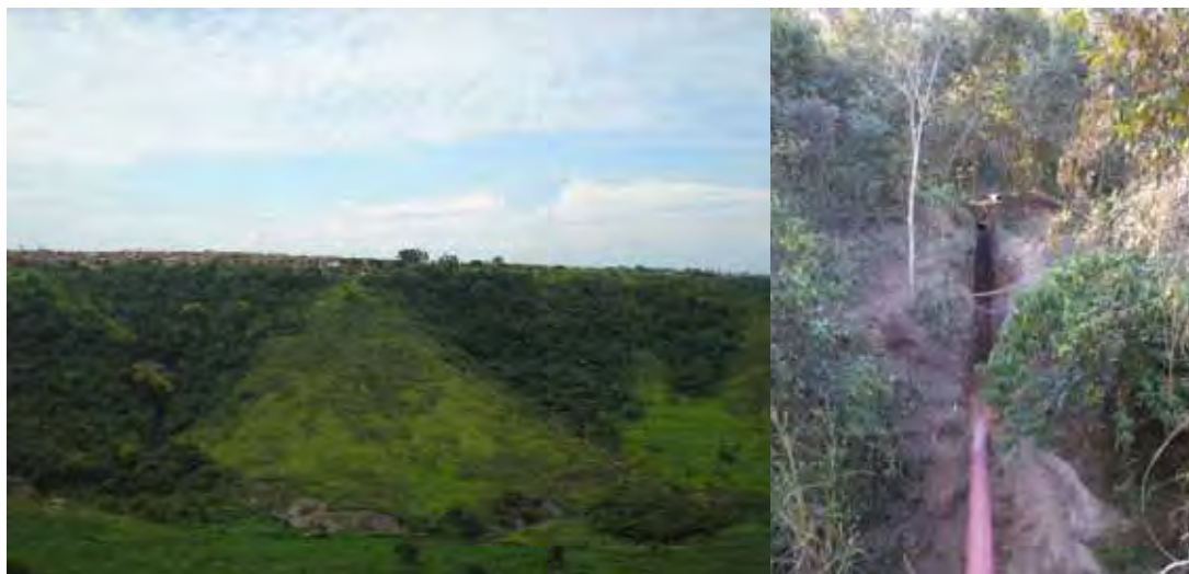
Figura 51: Na foto da esquerda pode-se ver uma rampa de colúvio, por onde alguns emissários descerão, visto na foto da direita.
