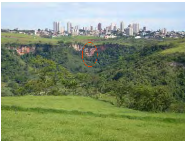
Figura 44: Ponto de lançamento de esgoto bruto na bacia do Córrego Barbosa. Foto tirada em 07/2008.
