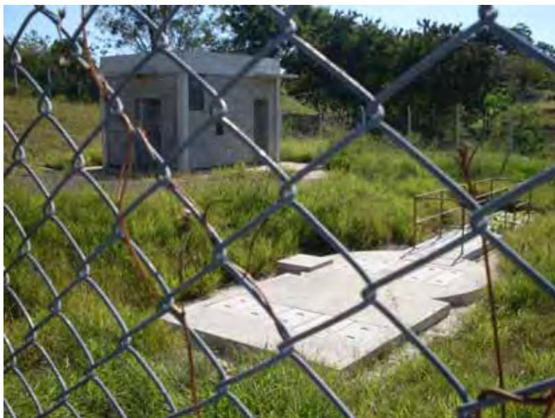
Figura 38: Estação elevatória do Subsistema Barbosa (bacia do Cascatinha) sendo construída. Foto tirada em 07/2009.
