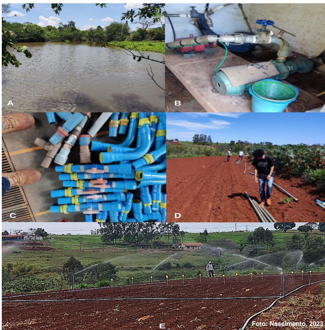
Figura 27 - Lago artificial usado como fonte de abastecimento de água (A); conjunto motobomba utilizado para fornecer água ao sistema de irrigação (B); tubos e conexões de engate prático com rosca (C); montagem do sistema de irrigação por aspersão (D); Sistema de irrigação montado e testado (E)
