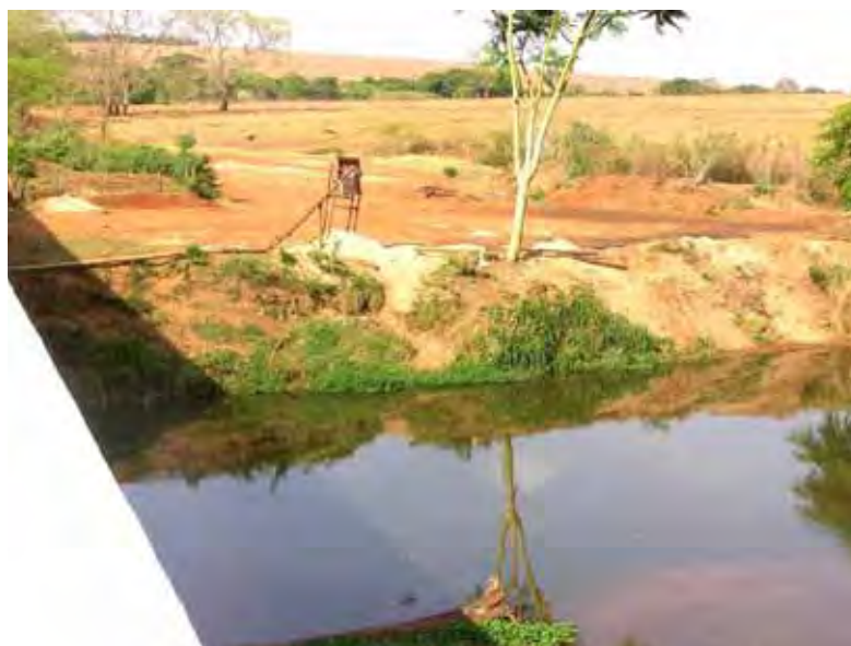
Figura 39. Dragagem ( em região de situação crítica) – ponte sobre a foz do rio Uberaba (765204 N – 7790629 E)
