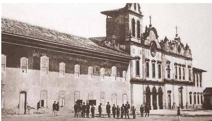
Figura 37: A fachada da Igreja da Ordem 3. a do Seráfico São Francisco, a primeira da direita para a esquerda, na foto, ainda está exatamente como Tebas a executou, em 1783.
