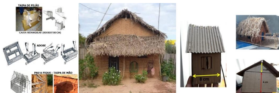
Figura 77: Construções em taipa e adobe
