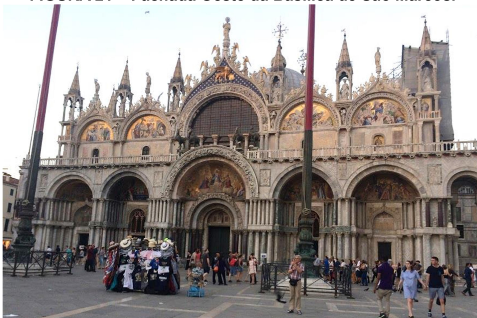
FIGURA 21 – Fachada Oeste da Basílica de São Marcos.
