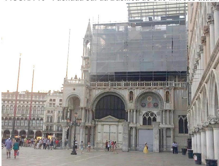
FIGURA 16 - Fachada sul da Basílica de São Marcos atual.
