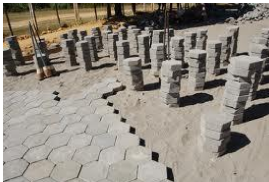
Figura 6. Pisos inter-travados, pré-moldados em concretos (Grupo de Pesquisa em Materiais de Construção e Estruturas).
