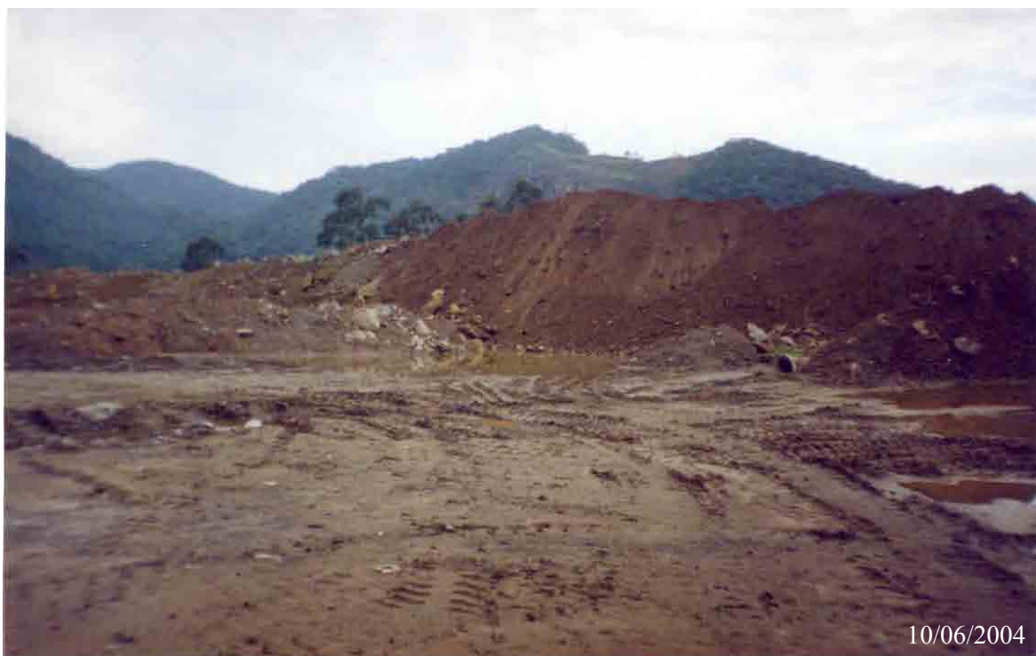
Figura 44 – M 5d – Pilha de material oriundo da limpeza da área de deslizamento. Pedreira Mongaguá, no município de Mongaguá.
