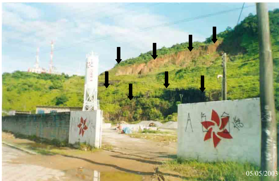
Figura 33 – M 2d – Cicatriz de deslizamento em encosta do morro da torre de TV, proximidades da chácara São João, no município de Mongaguá.
