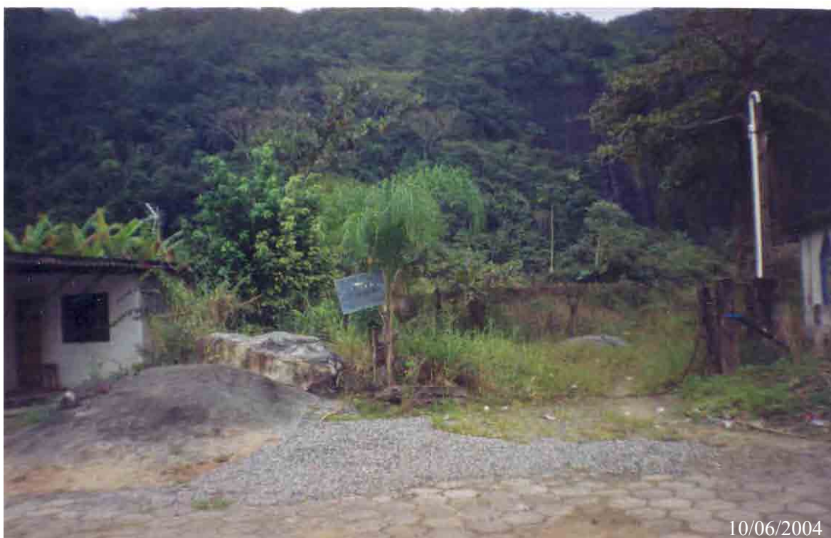
Figura 42 – M 5d – Placa inutilizada com indicação de risco à população. Avenida Olindo Tamagnini, ao lado da residência de nº 780, no município de Mongaguá.
