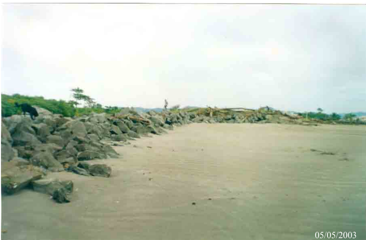
Figura 46 – P 1i – Enrocamento orientando trecho do rio Preto, na faixa de areia da praia, bairro Cidade Balneária de Peruíbe, no município de Peruíbe.
