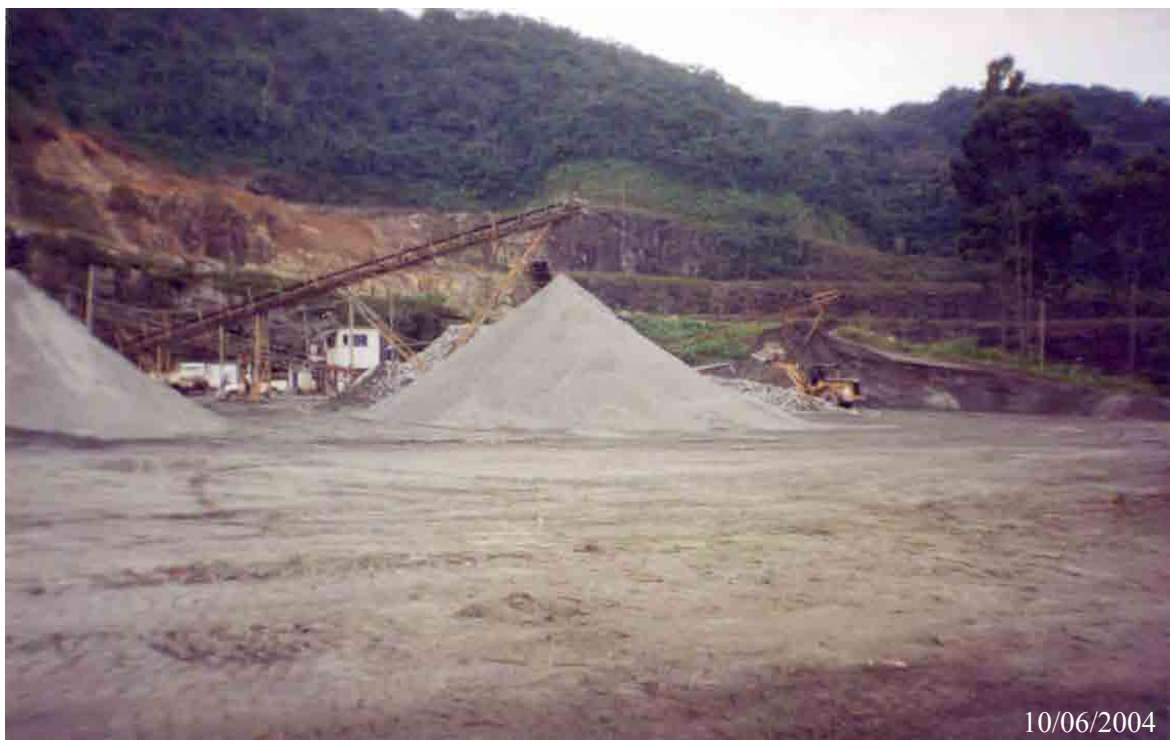
Figura 43 – M 5d – Aspectos da Pedreira Mongaguá em atividade. Sinais de deslizamento acumulado na cota 100 m. Obras de limpeza executadas por homens e máquinas. Estrada do Poço, no município de Mongaguá.
