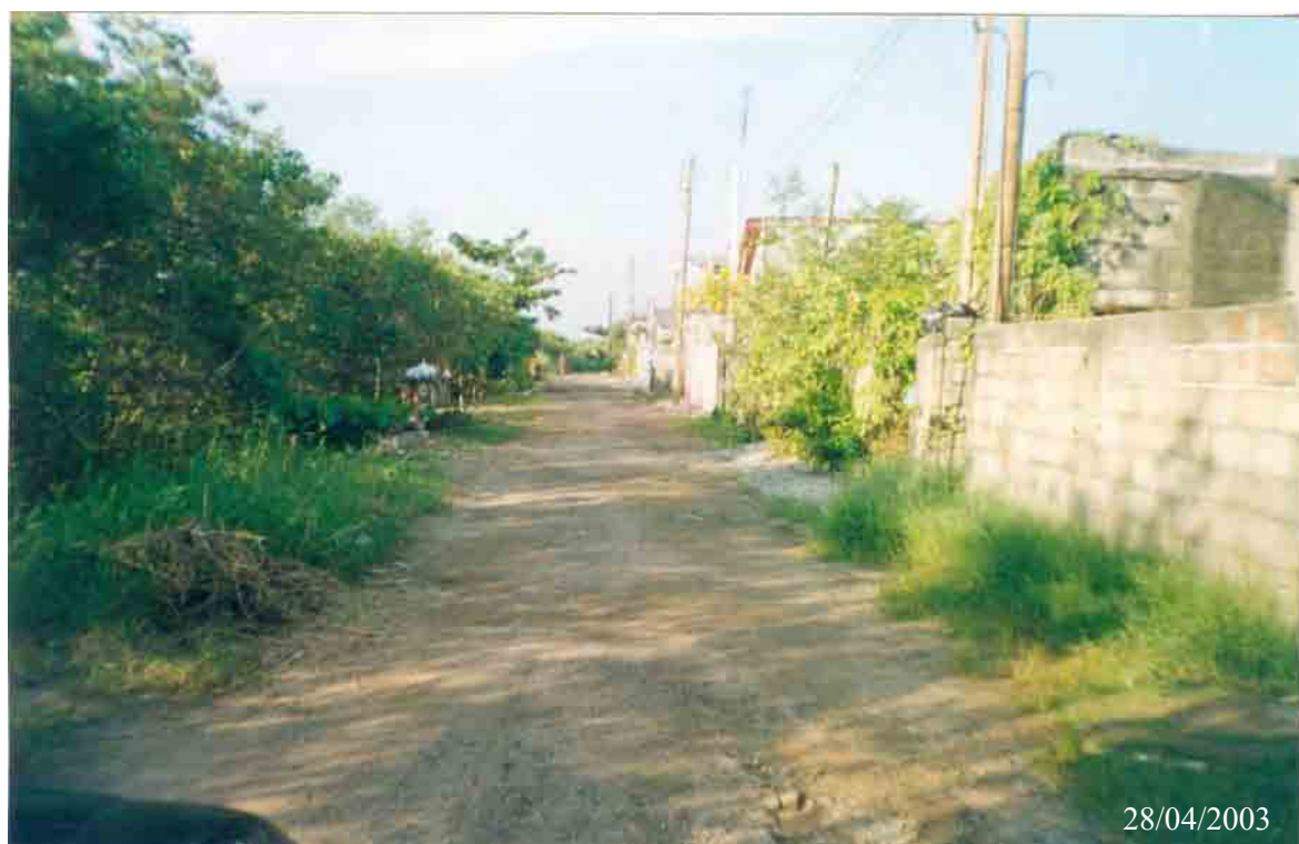
Figura 22– I 4i – Aspectos da ocupação consolidada junto às margens do rio Campininha, Vila Santo Amaro, no município de Itanhaém.
