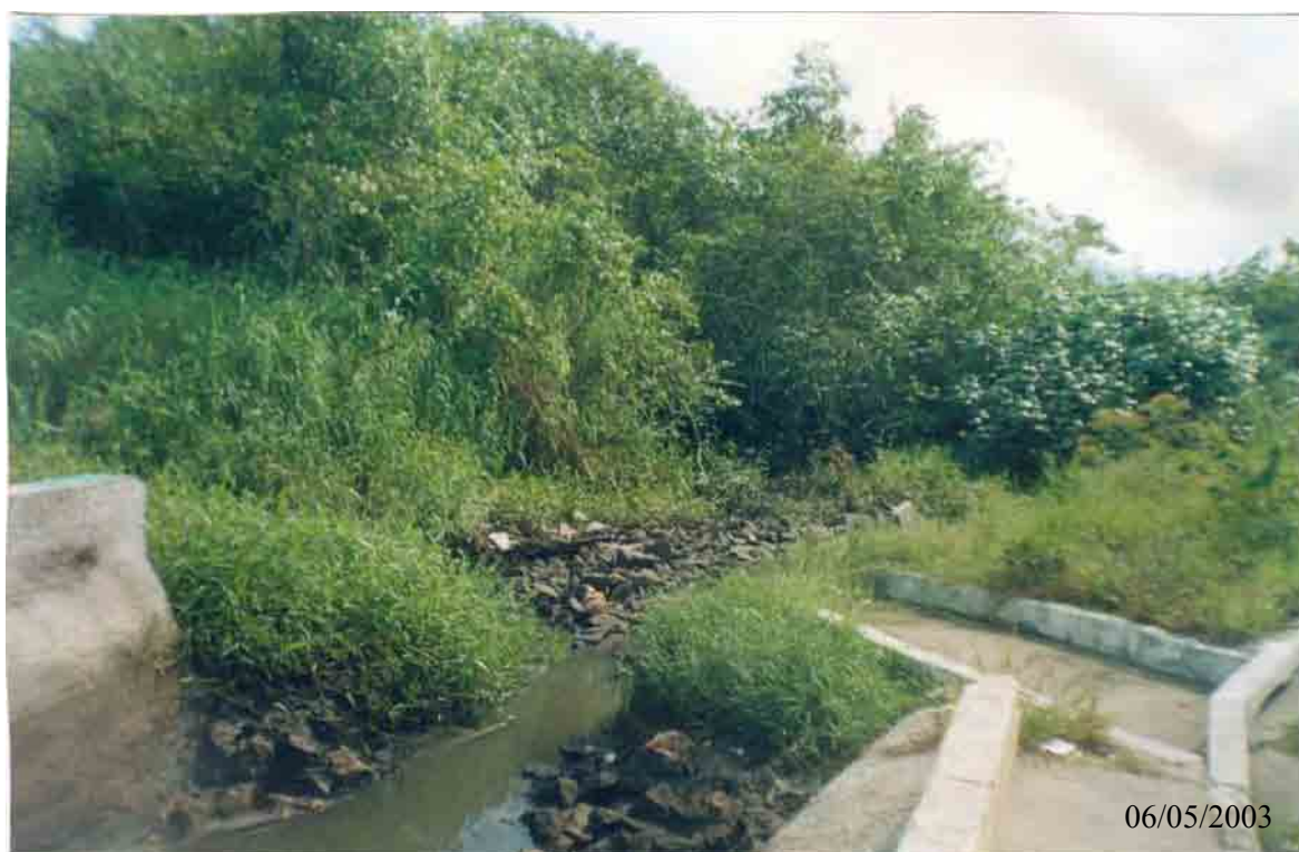
Figura 56 – PG 1i – Área sujeita a inundações, junto ao rio Icaraú, bairro Jardim Quietude, no município de Praia Grande.
