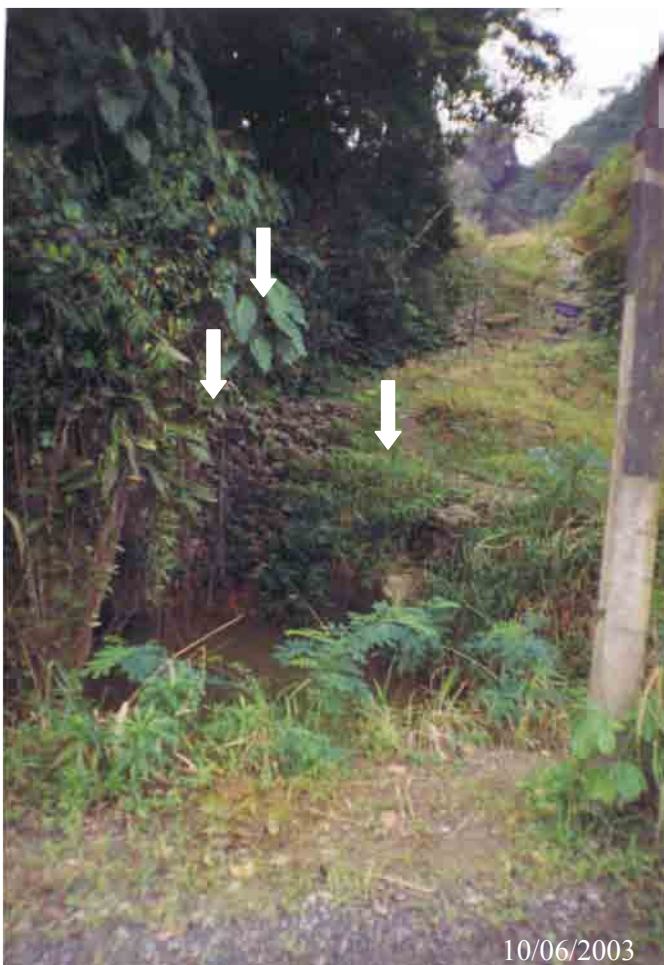
Figura 39 – M 4d – Aspecto de deslizamento expondo rocha de enrocamento de contenção. Estrada do Poço (lado morro), no município de Mongaguá.
