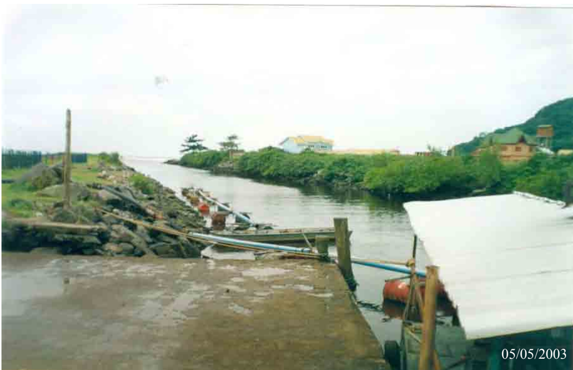
Figura 45 – P 1i – Aspecto da desembocadura retelinizada do rio Preto, bairro Cidade Balneária de Peruíbe, no município de Peruíbe.
