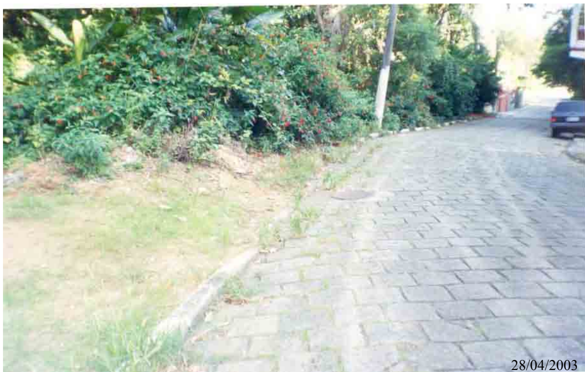
Figura 18 – I 2d – Sinais de rastejo e cicatriz de escorregamento na encosta junto à rua João Selymes, morro Praia do Sonho, levando risco à via de acesso, à moradia e ao poste de energia, no município de Itanhaém.
