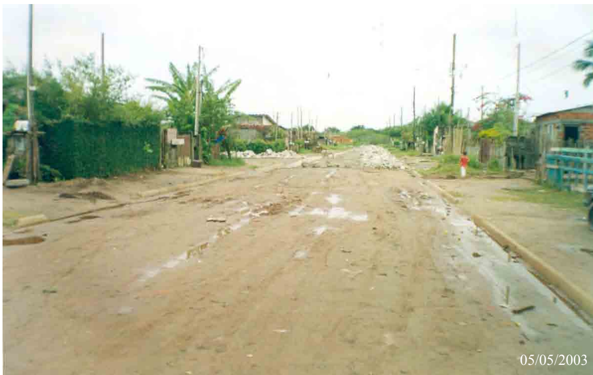
Figura 49 – P 2i – Aspecto do trabalho de pavimentação em área sujeita a inundação, localizada junto à margem esquerda do rio Preto, vila Veneza, no município de Peruíbe.
