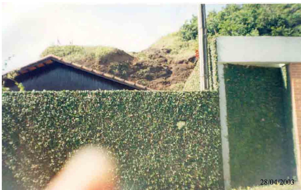
Figura 21– I 3d – Encosta desmatada levando risco à moradia na avenida Wallace Artur Skerat, morro da Praia do Sonho (lado da serra), no município de Itanhaém.
