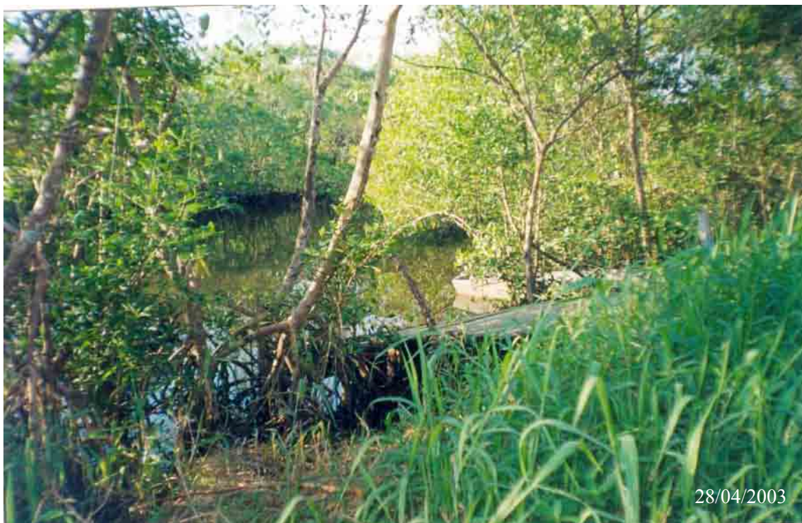
Figura 24 – I 4i – Aspecto da obstrução da drenagem do rio Campininha, Vila Santo Amaro, no município de Itanhaém.
