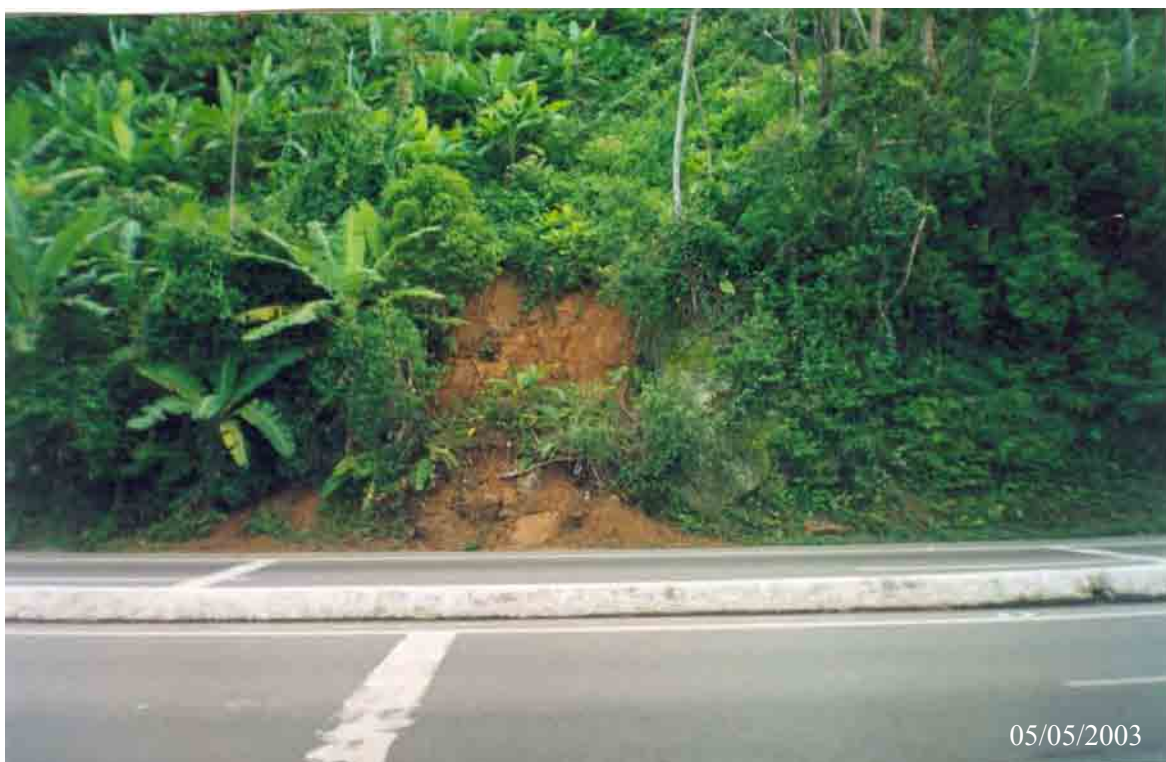
Figura 32 – M 1d – Cicatriz de deslizamento em encosta recoberta por vegetação inadequada, junto à rodovia Padre Manoel da Nóbrega, nas proximidades do centro do município de Mongaguá.
