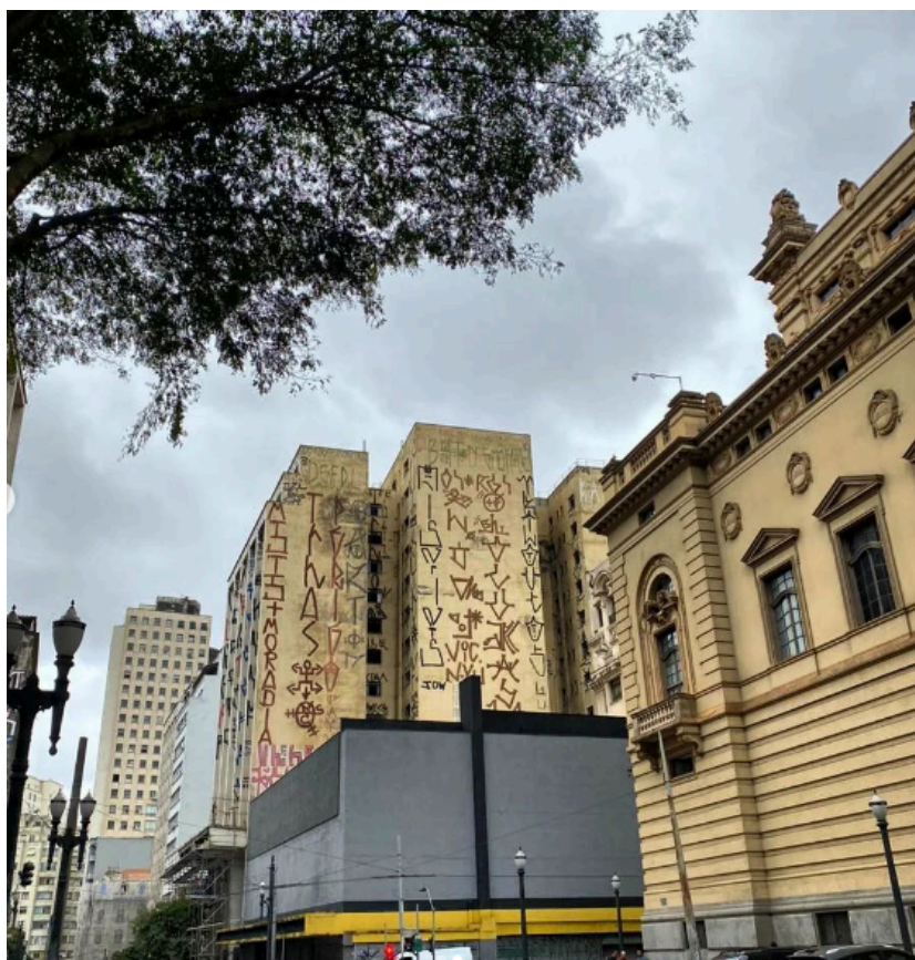
Figura 11 - Agenda de pixos feitos de rapel, no prédio do antigo Cine Marrocos, no centro de São Paulo, prédio ocupado pelo movimento por moradias MSTs.
