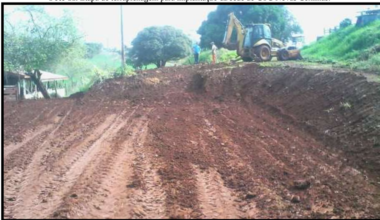
Foto 11. Etapa de terraplenagem para implantação da sede do CTG Novas Coxilhas.
