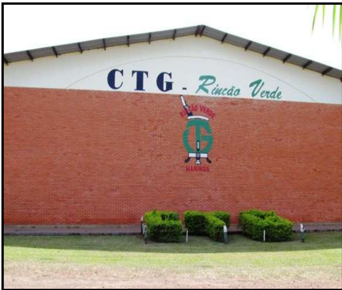
Foto 13. Fachada do CTG Rincão Verde de Maringá.
