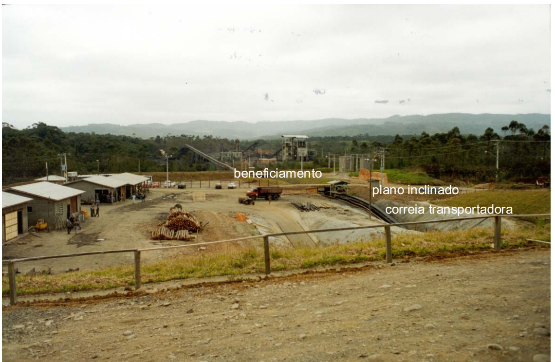
Foto 7 - Vista geral das instalações da Mina Trevo, Siderópolis (SC).
