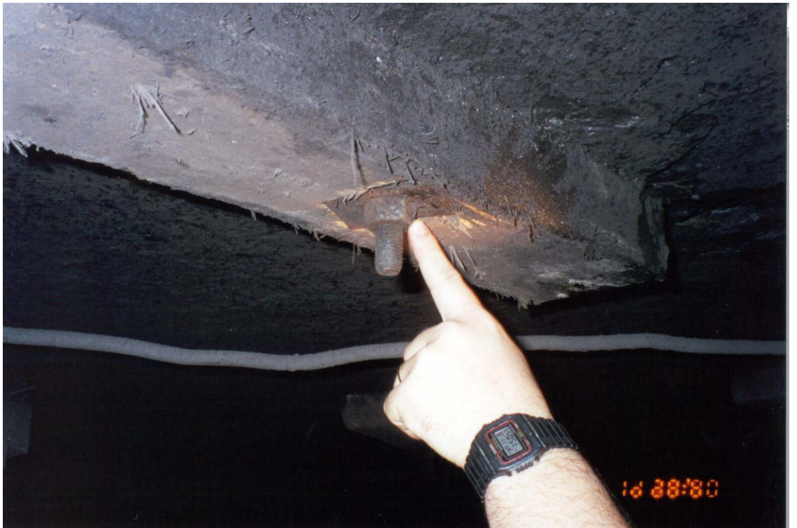
Foto 5 - Detalhe do parafuso de sustentação do teto da galeria. A viga de madeira serve como orientação caso o teto esteja cedendo, a arruela penetra na madeira, Mina Trevo, Siderópolis (SC)
