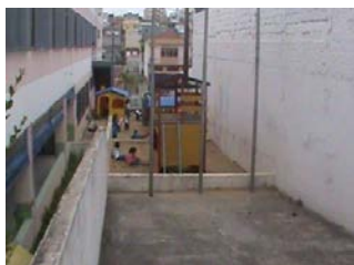
Ilustração 14 - Vista do tanque de areia de frente da escola - detalhe para grades nas janelas
