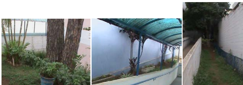
Ilustração 24 - Canteiros laterais das rampas
