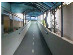
Ilustração 11 - Rampa de acesso ao andar inferior: da curva para o refeitório
