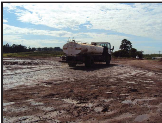
Figura 11. Recirculação de lixiviado na superfície do aterro com auxílio de caminhão-tanque.
