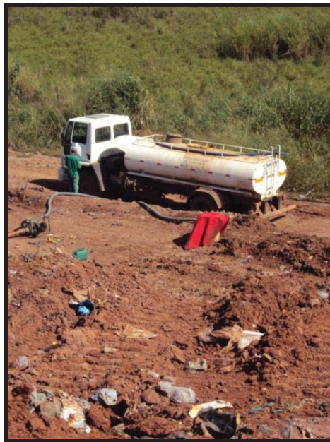
Figura 10. Coleta de lixiviado por caminhão-tanque para posterior recirculação na superfície do aterro.
