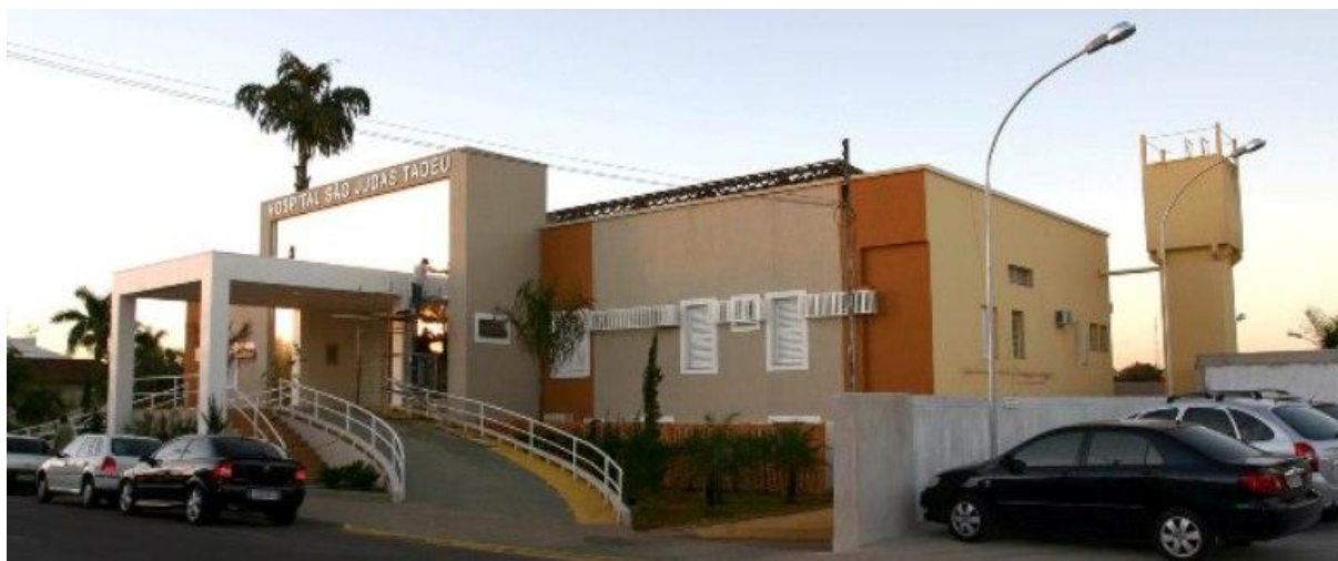
Figura 02 – Hospital São Judas Tadeu - Fundação Pio XII
