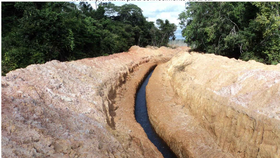
Figura 44. Desvio das águas da Barragem Duduca. Captura da imagem: 31 de maio de 2019 em visita exploratória para conhecimento da área.
