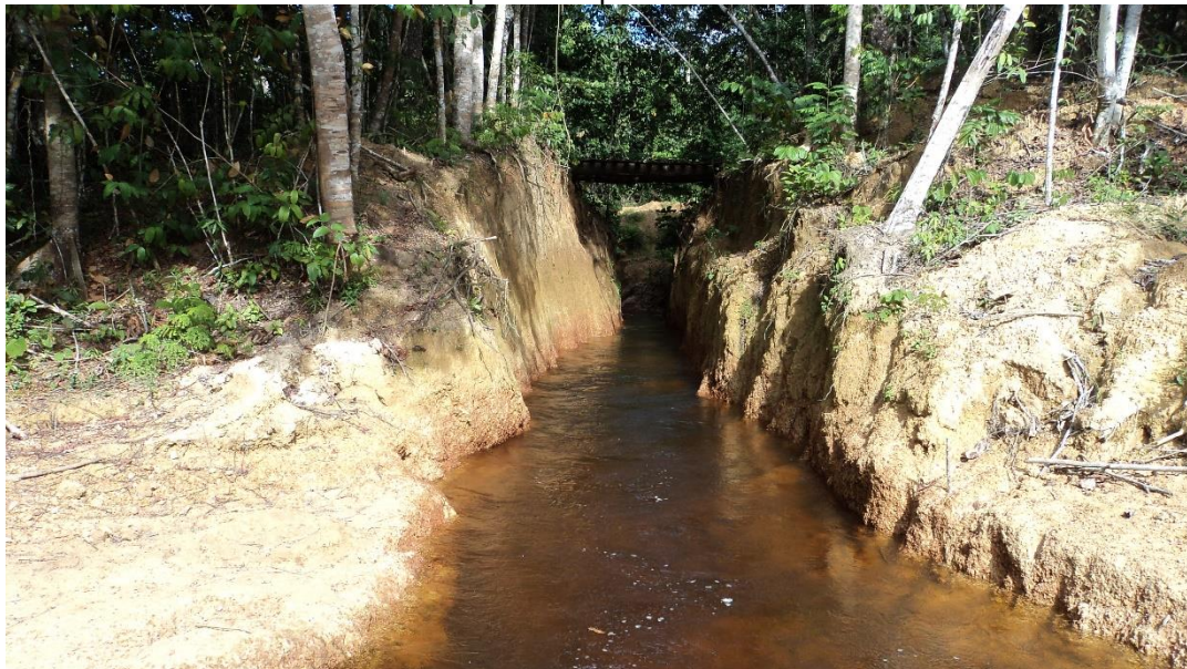
Figura 41. Desvio do Igarapé Japiim para ocupação da cava. Captura da imagem: 01 de junho de 2019 em visita exploratória para conhecimento da área.
