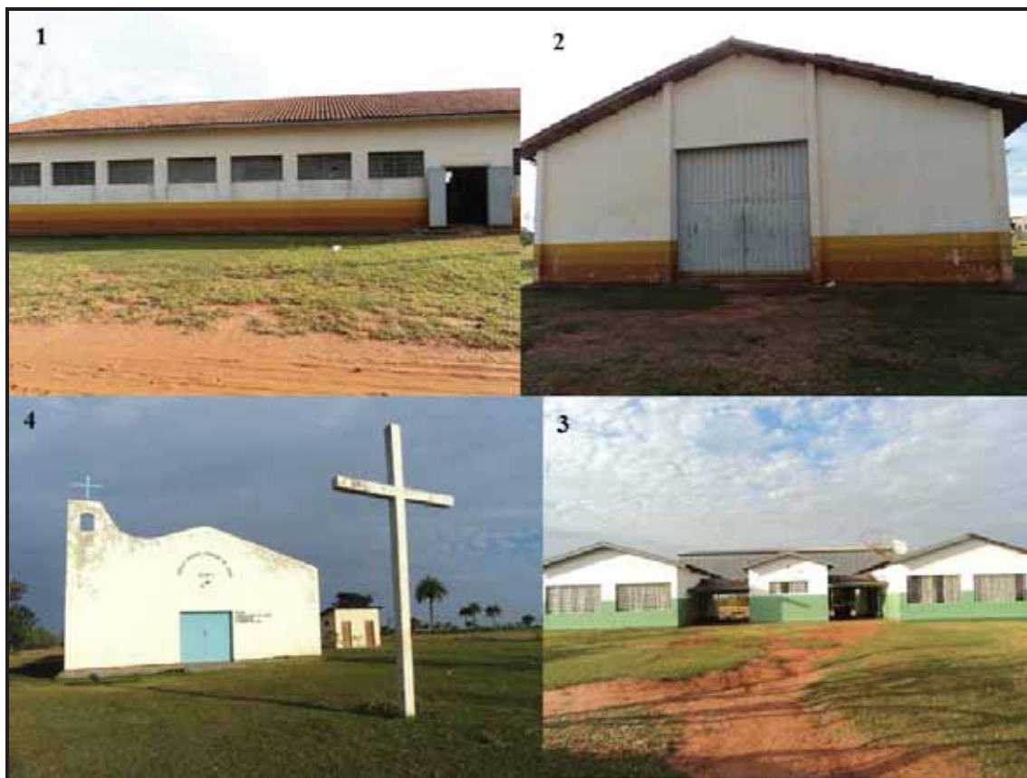
Figura 4 - Centro Comunitário Setor I
