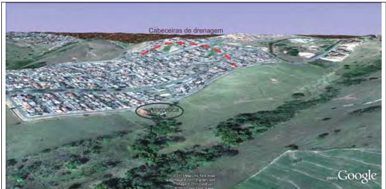
Figura 16: Cabeceiras de drenagem nos conjuntos habitacionais Humberto Salvador e Augusto de Paula. Observa-se que a instalação dos loteamentos não levou em conta a morfologia do relevo, alterando-o consideravelmente bem como a dinâmica de escoamento das águas pluviais. Observa-se a formação de erosão linear nas vertentes decorrentes dessa alteração e do aumento do escoamento superficial.
