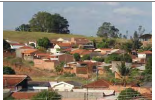
Figura 15: Corte de talude no Conjunto Habitacional Brasil Novo.
