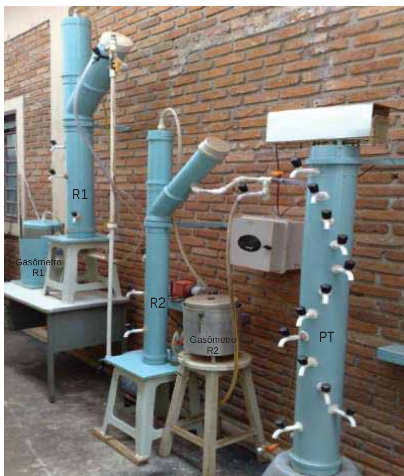
FIGURA 5. Unidade Experimental composta pelo sistema de tratamento anaeróbico em dois estágios com reatores UASB (R1 e R2) seguidos de pós-tratamento com lodos ativados em batelada (PT), construídos em escala de bancada.
