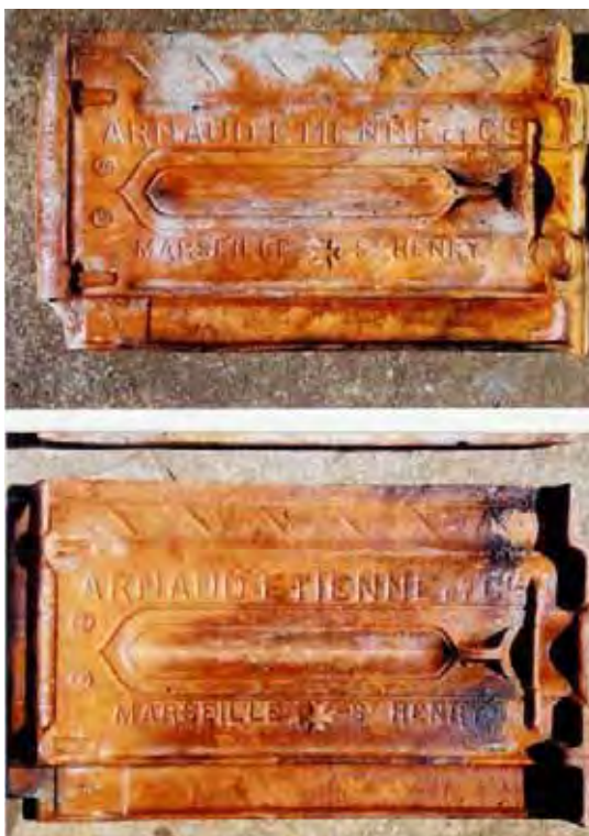
ILUSTRAÇÃO 3 – Telha Marseille St. Henry, da sede da Fazenda Monte Alegre. 23 Fonte: MH. Foto: SMES
