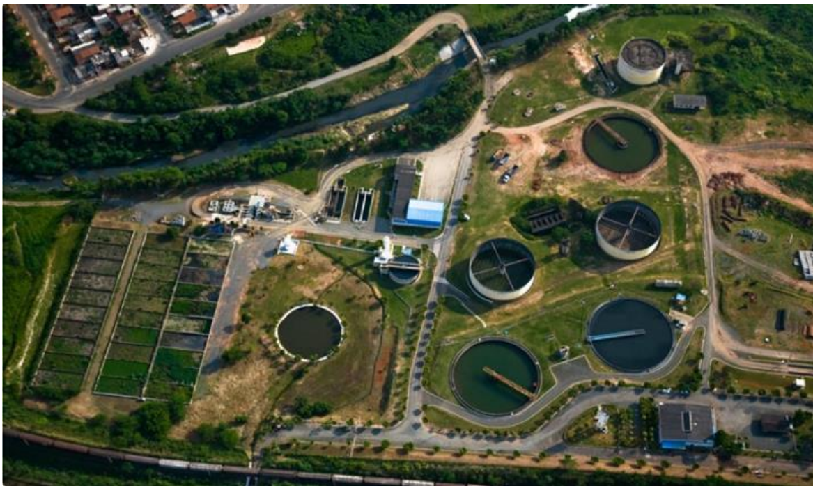
Figura 1 – Estação de tratamento de esgoto (ETE).
