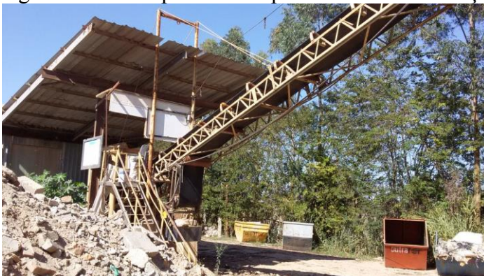
Figura 25 – Setor primário de peneiramento e trituração da usina RCC
