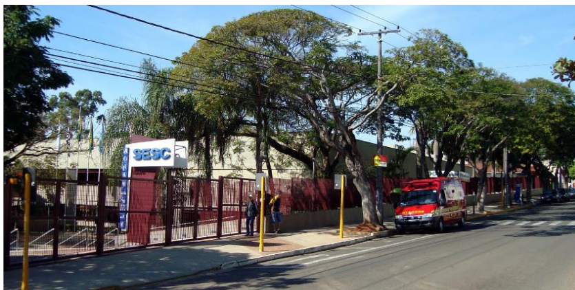
Figura 11 – Fachada do SESC Bauru
