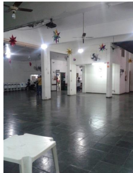
(b) Vista do ventilador de parede
