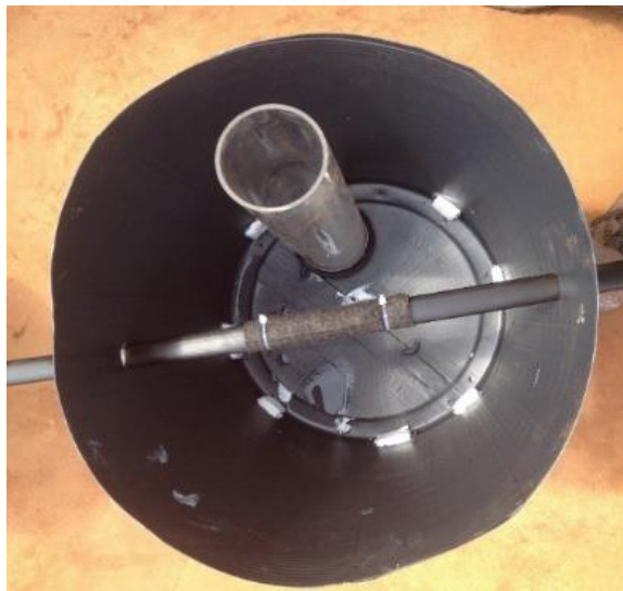
Figura 3. Geotêxtil fixado com braçadeira de plástico diretamente no emissor.
