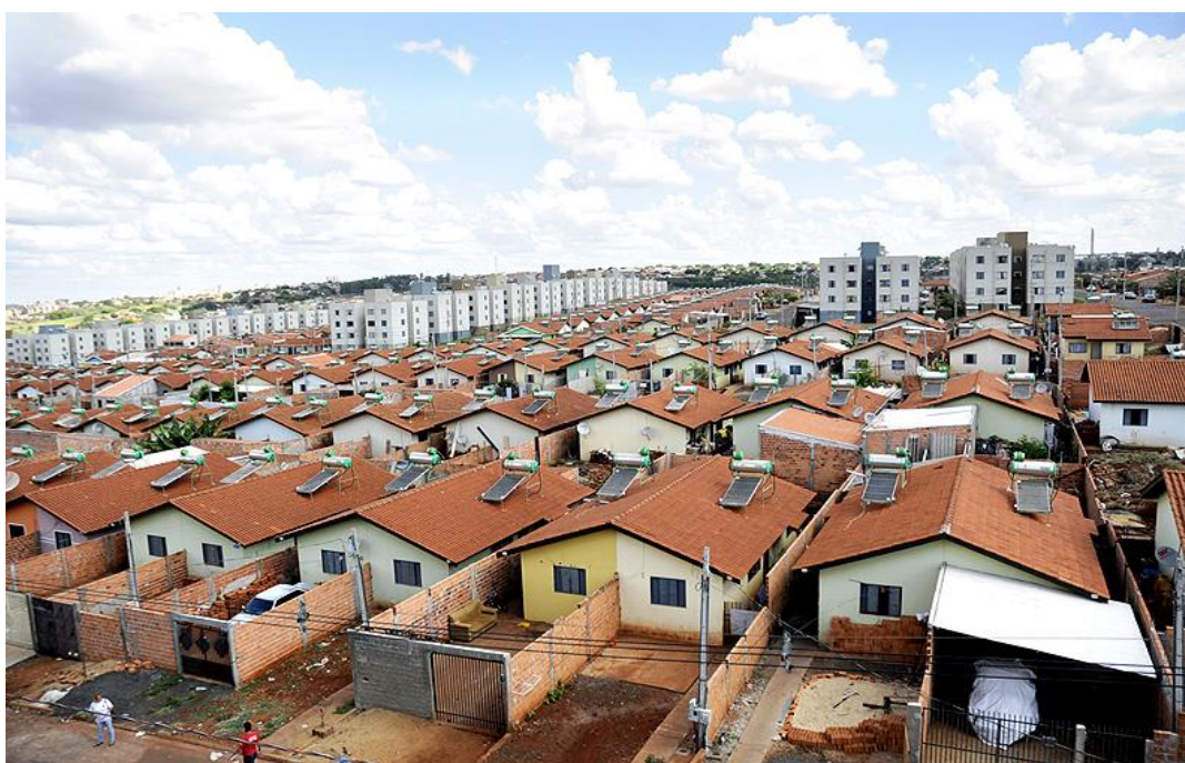
Figura 20. Residencial Vista Bela
