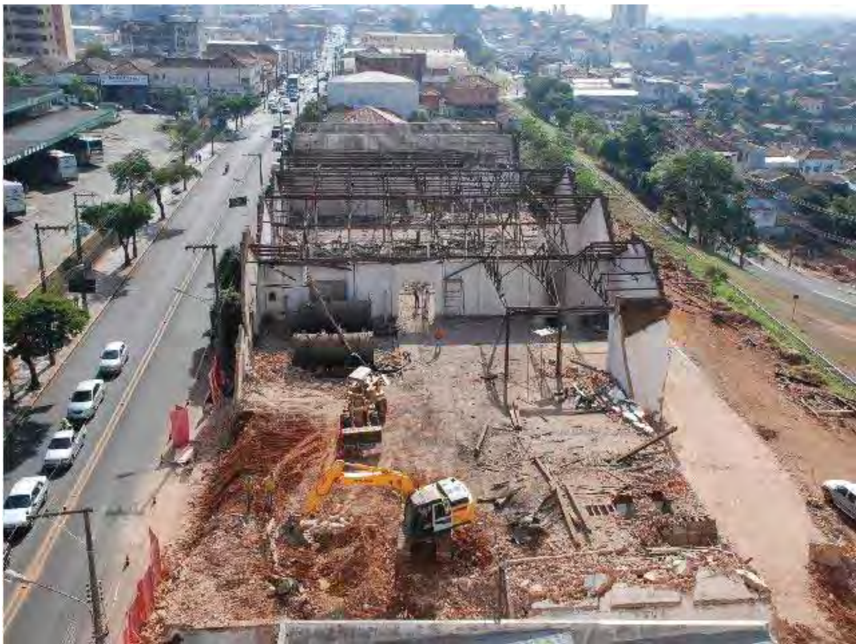
Imagem 17 – Demolição do expurgo
