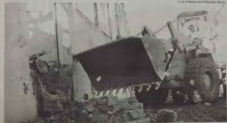
Paredes construídas no início de 1940 são derrubadas para dar lugar ao Poupatempo
