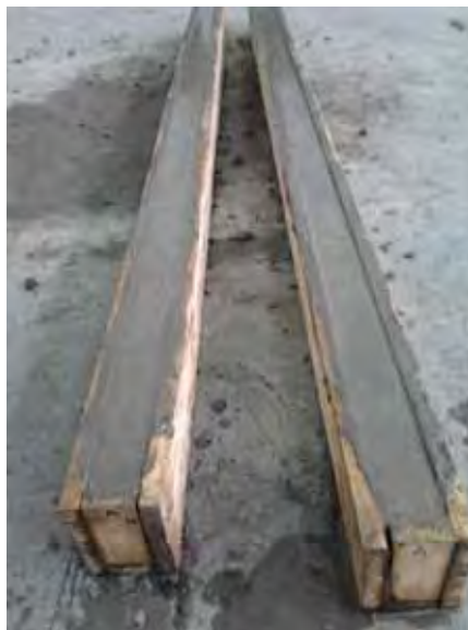
Figura 24: Vigas concretadas. Fonte: Autor.
