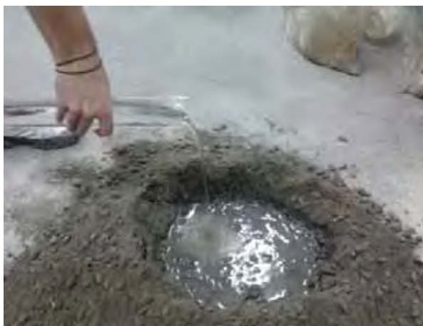
Figura 23: Preparação do concreto. Fonte: Autor.
