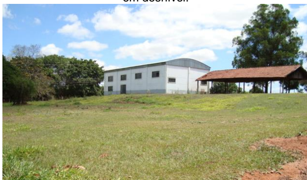
Figura 2: Espaço destinado à construção do Parque. Área em desnível.
