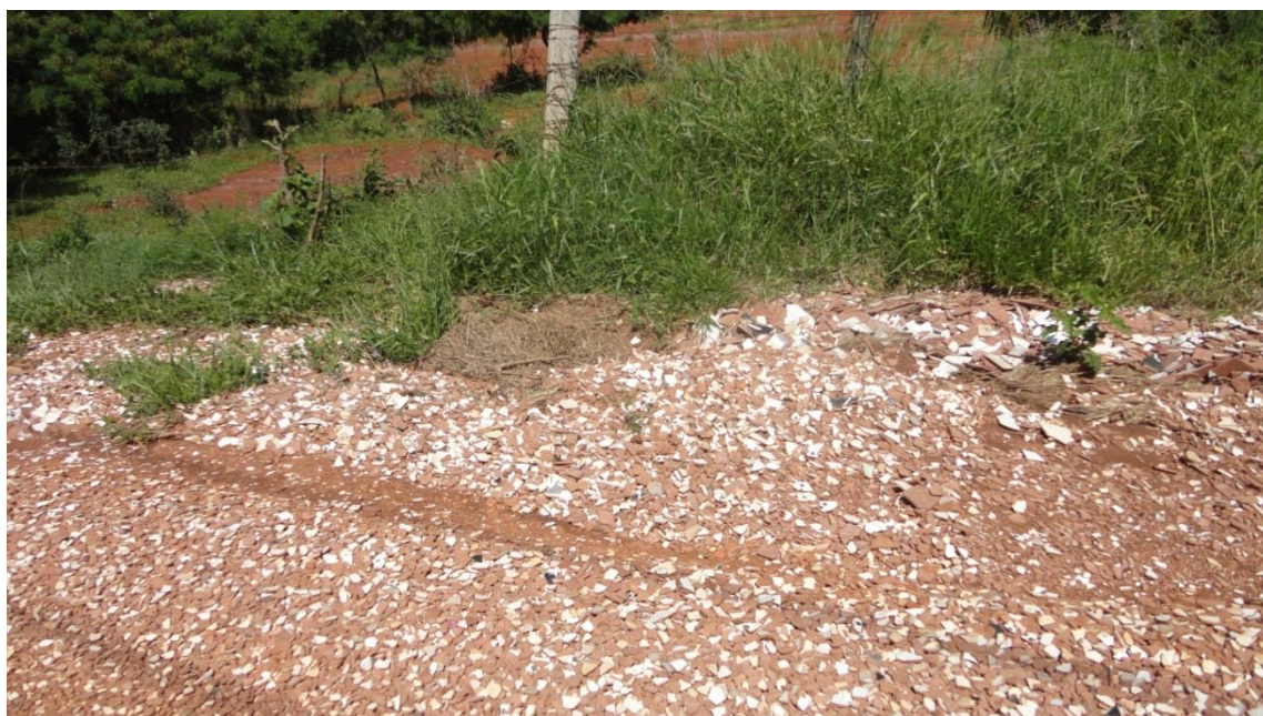
Figura 6 – Estrada de acesso aos pesqueiros coberta por resíduos de cerâmica.
