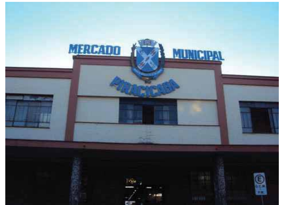
Figura 16 – Fachada Principal do Mercado de Piracicaba [Fonte: FRATANTONIO, 2011.]
