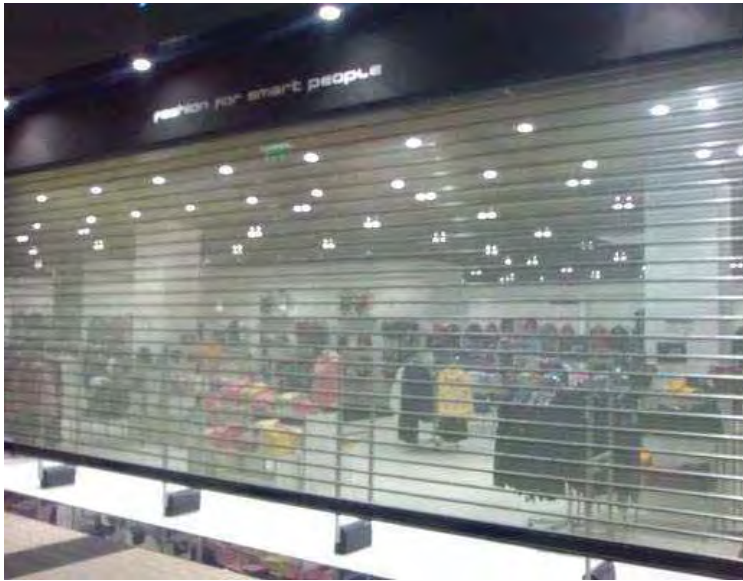
Figura 100 – Porta de aço automática
