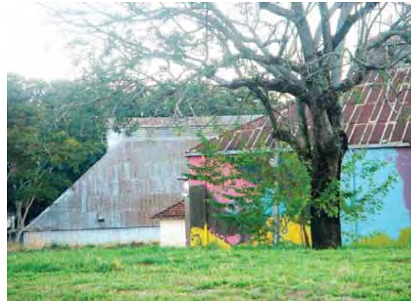
Figura 40 – Galpão e IBC [Fonte: FRATANTONIO, 2011.]
