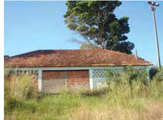
Figura 66 – Edificação adjacente [Fonte: FRATANTONIO, 2011.]
