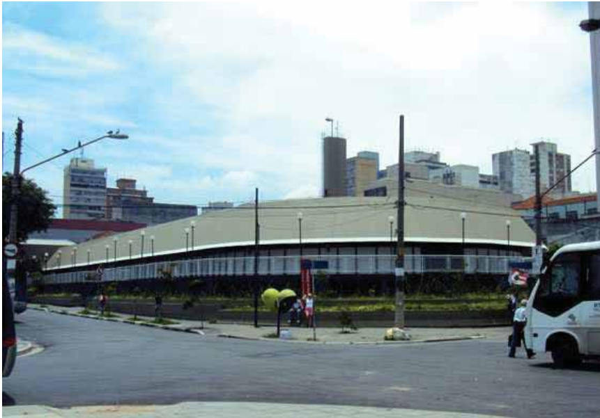
Figura 05 – Vista do Mercado de Pinheiros [Fonte: FRATANTONIO, 2011.]
