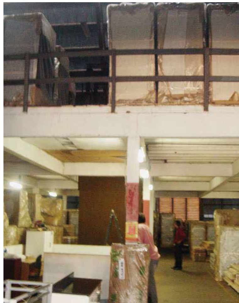
Figura 70 – Mezanino de madeira [Fonte: FRATANTONIO, 2011.]
