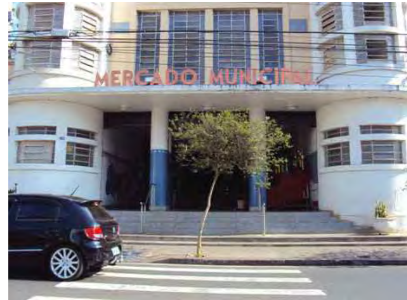
Figura 14 – Fachada Principal de Mercado de São José do Rio Preto [Fonte: FRATANTONIO, 2011]
