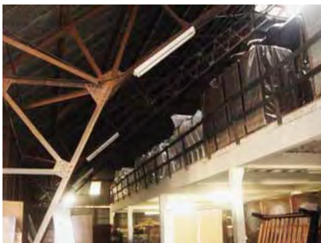
Figura 69 – Estrutura interna de aço e mezanino de madeira [Fonte: FRATANTONIO, 2011.]
