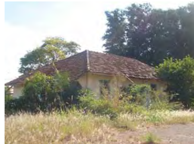
Figura 67 – Edificação adjacente [Fonte: FRATANTONIO, 2011.]
