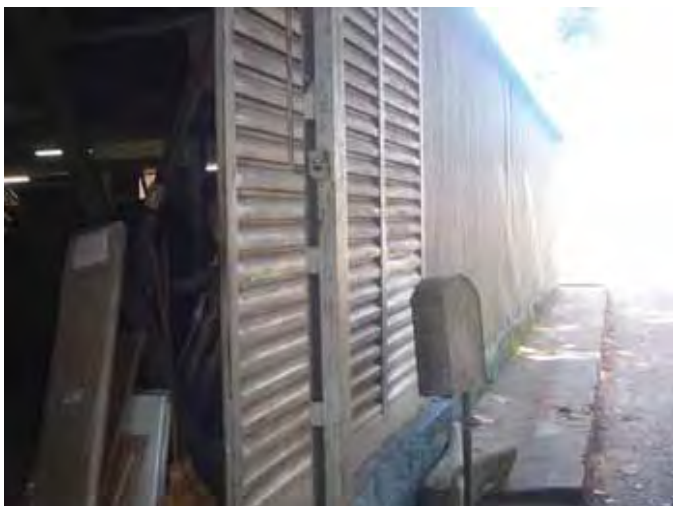
Figura 68 – Revestimento Galpão [Fonte: FRATANTONIO, 2011.]
