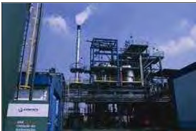
Figura 3.2: Incinerador da Essencis, (Fonte: site da Essencis)
