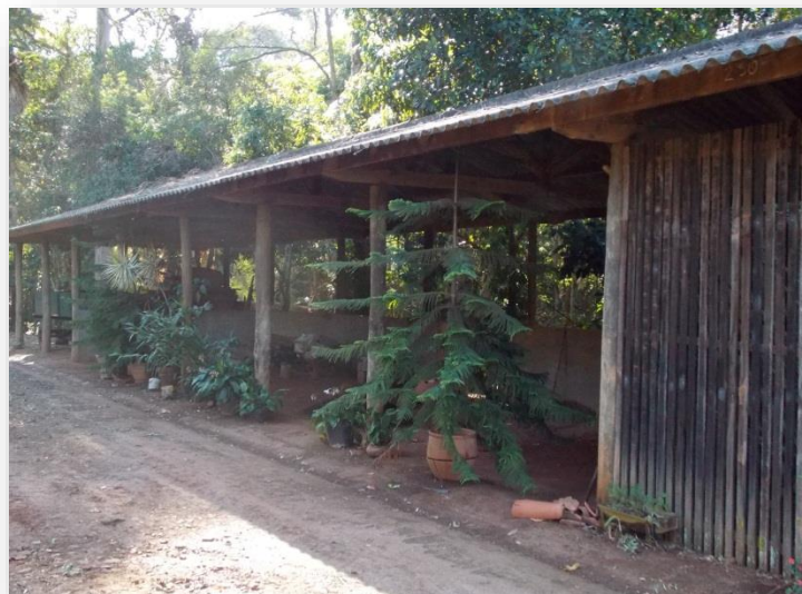
Fotografia 2: Galpão do maquinário usado na EESRPQ.
