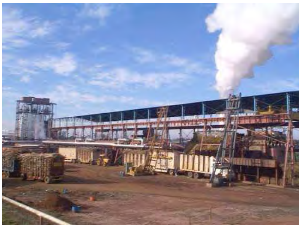
Figura 15: Vista geral da recepção e lavagem da cana da Usina Dela Colleta Fonte: www.coletta.com.br
