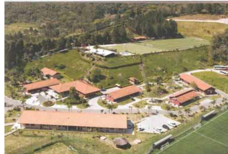
Figura 20. Vista aérea do CFA contemplando as edificações
