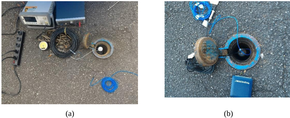
Figura 4.11 – Fotografia do experimento realizado para a estimativa da velocidade de propagação do ruído de vazamento; (a) Atuador LMS instalado no ponto de acesso juntamente com um acelerômetro PCB; (b) Geofone instalado juntamente com um acelerômetro no ponto de acesso.
