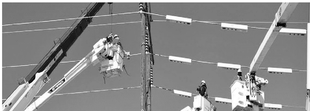
Figura 07: D-FACTS ao longo da linha de distribuição
