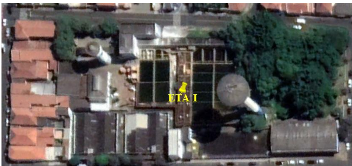
Figura 3: Imagem aérea da localização da ETA I Fonte: Google Earth, 2021.
