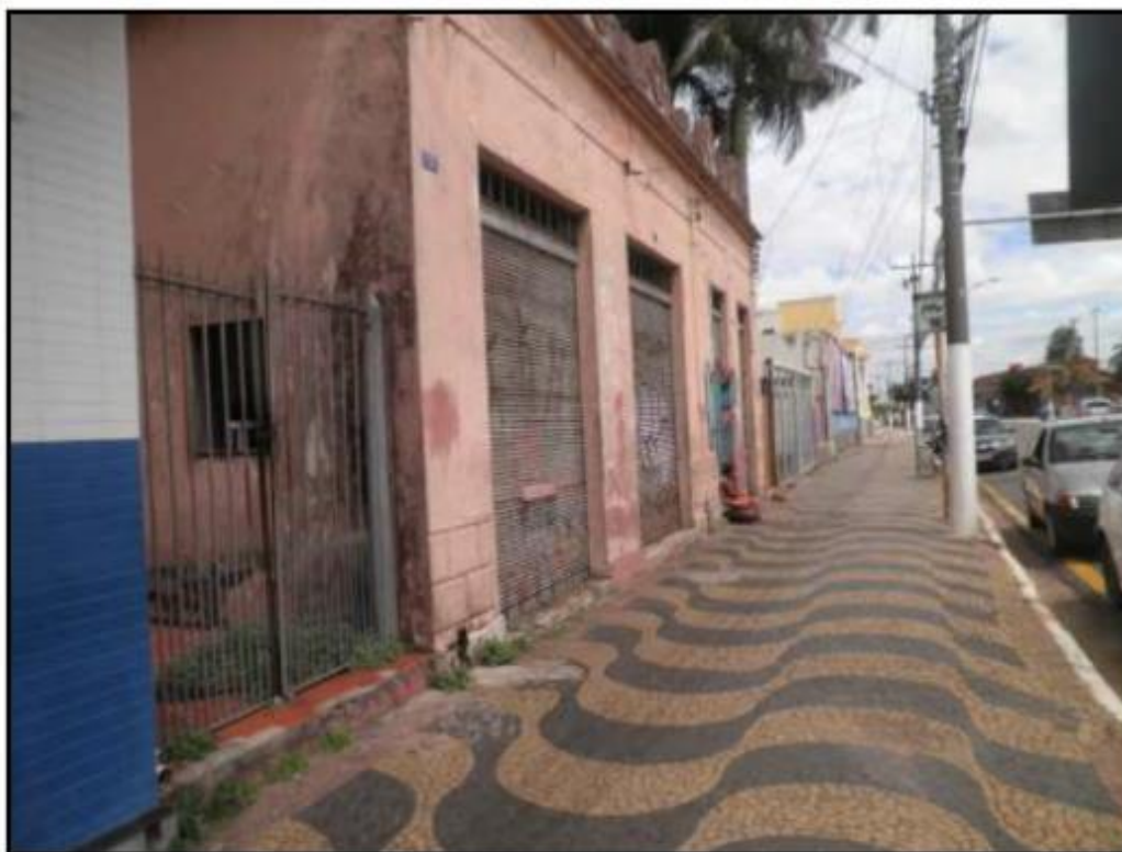
Fotografia 9 – Marília (SP). Imóvel desocupado na Avenida Sampaio Vidal. 2015.
